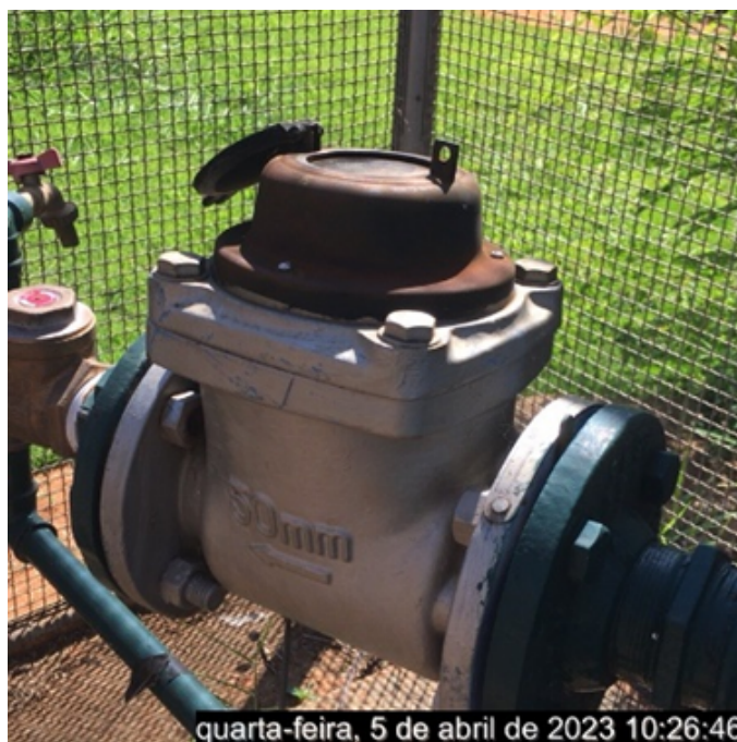
Fonte: Coordenadoria de Engenharia – CEASA Campinas (2023)
