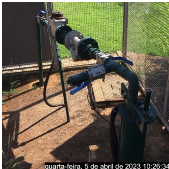
Fonte: Coordenadoria de Engenharia – CEASA Campinas (2023)
