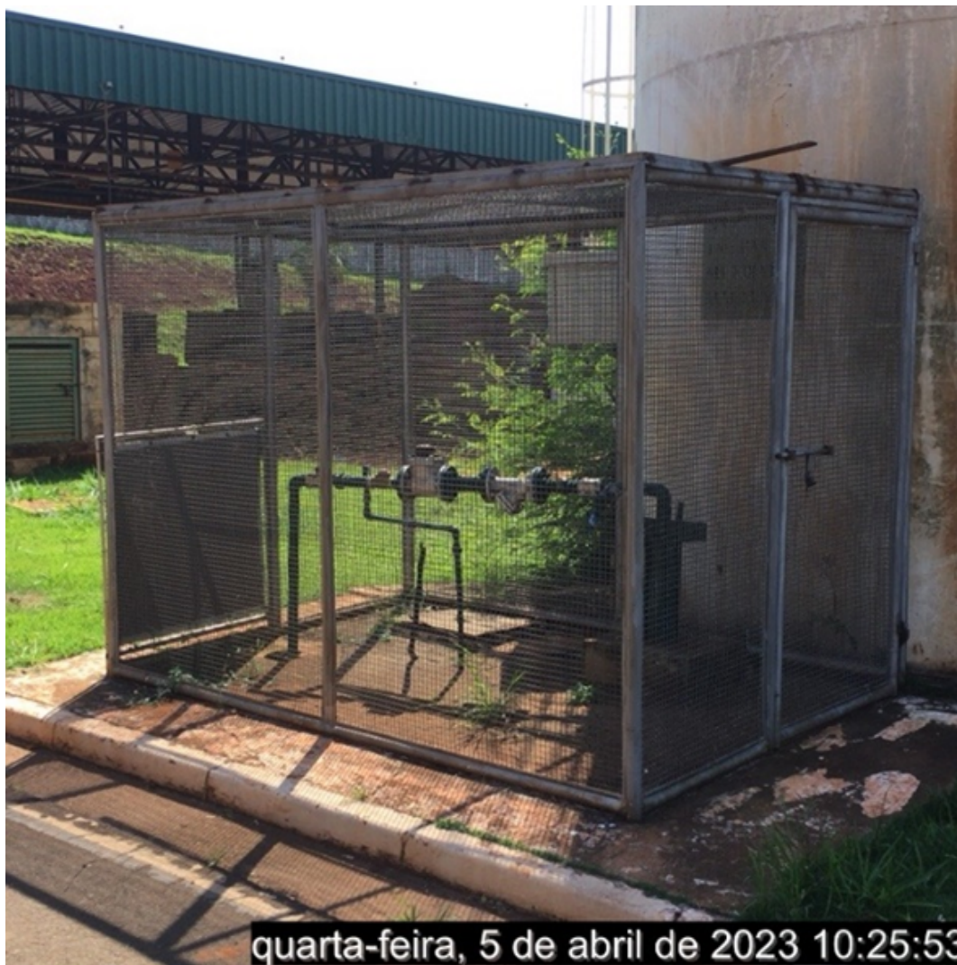
Fonte: Coordenadoria de Engenharia – CEASA Campinas (2023)
