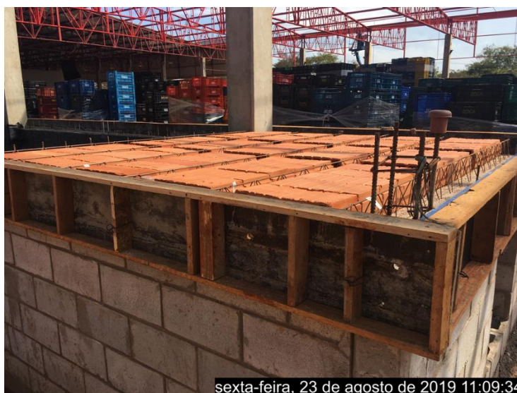
Figura 16 – Exemplo de acabamento que será aceito para elementos de alvenaria aparente
