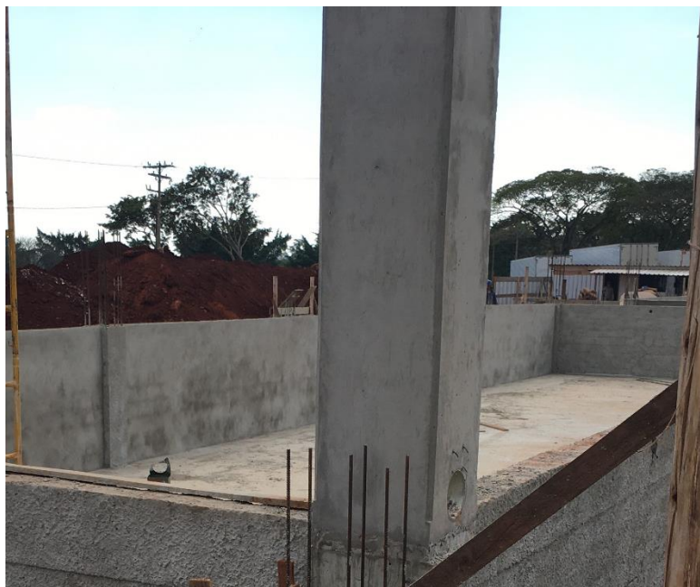
Figura 14 – Exemplo de superfície (pilar) que será aceita para elementos de concreto aparente
