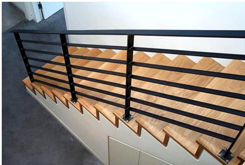
Figura 21 – Exemplos de acabamento serão aceitos para guarda-corpos, corrimãos e bate-rodas (exclusive bitolas dos perfis)
